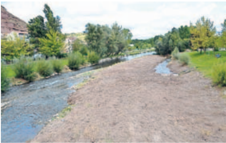
El Najerilla, aguas abajo del puente de San Juan, tras la limpieza. :: P.J.P.
